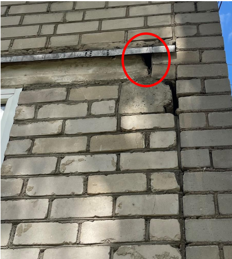
Pav. 14. Balkonų defektai: atskilęs balkono perdangos plokštės betonas
