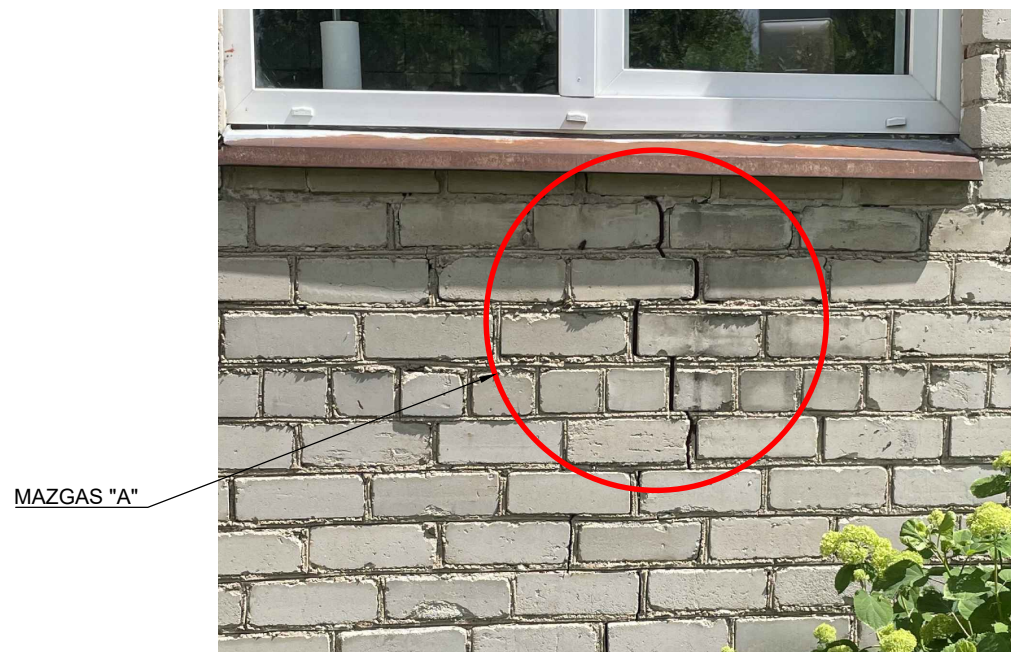
3. Strypų įkljavimas cheminio tvirtinimo derva KEM-UP (arba analogas)
