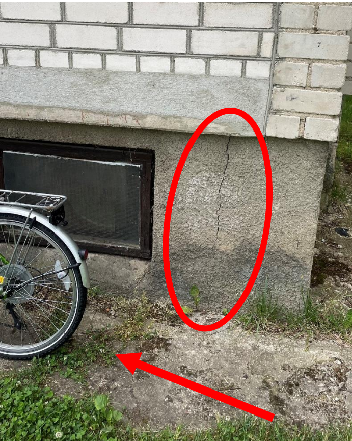
Pav. 7. Cokolio ir nuogrindos defektai
