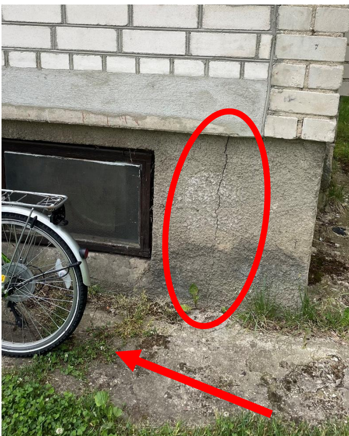
Pav. 7. Cokolio ir nuogrindos defektai
