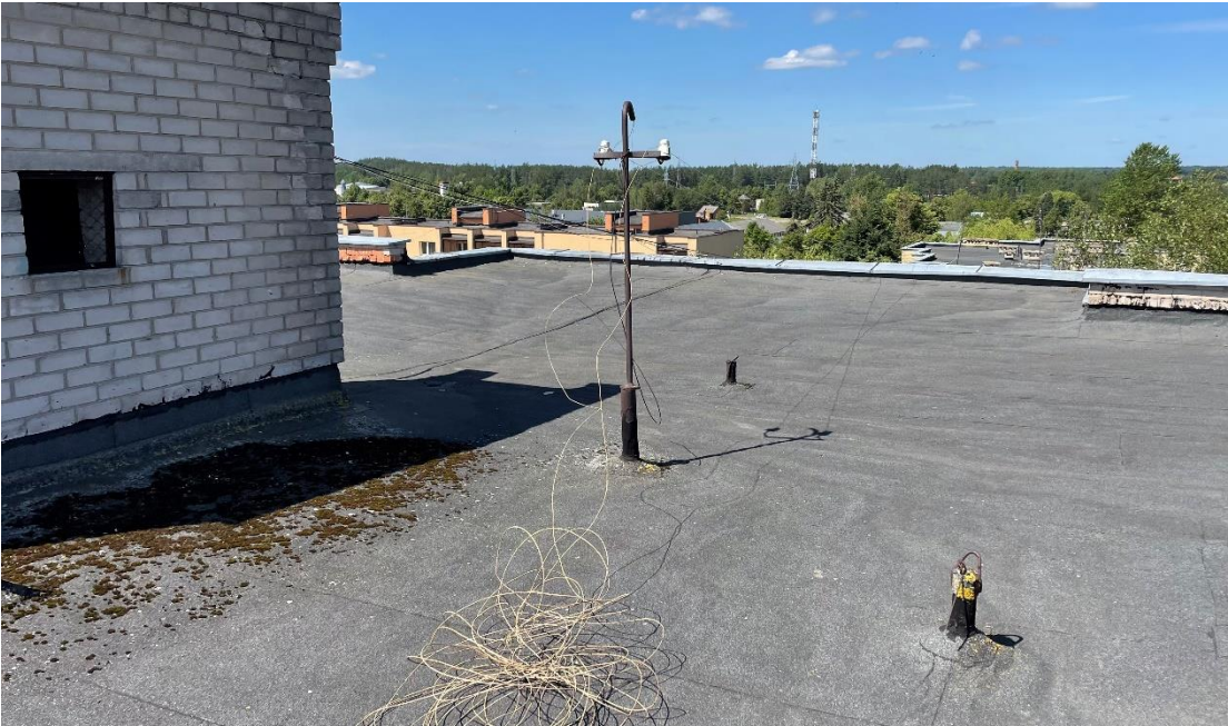
Pav. 14. Bendra stogo būklė
