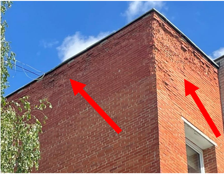
Pav. 12. Sienų defektai: ištrupėjęs plytų mūras
